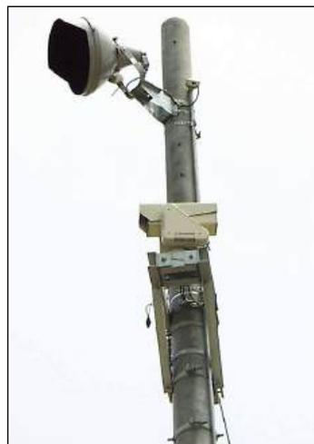
映像・音声・制御を光ファイバ 1 本で伝送。数十 km の長距離化ができ、落雷対策として最適。
